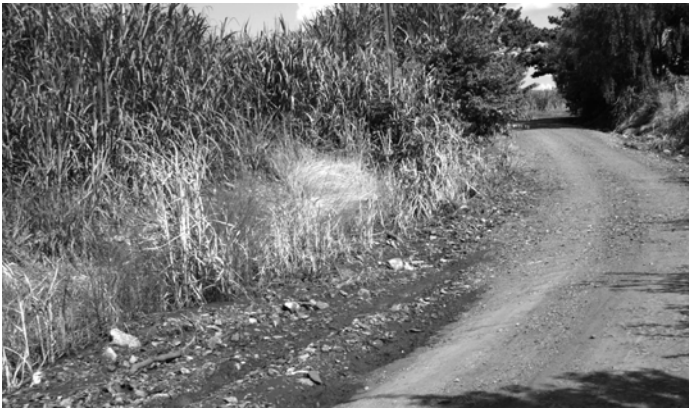
Trecho da mesma estrada antes da pavimentação
