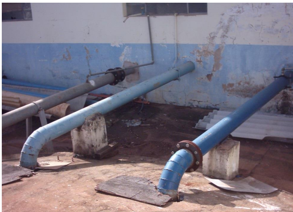
Figura 22. Tubulações de sucção da Casa de Bombas no. 01 da ETA.
