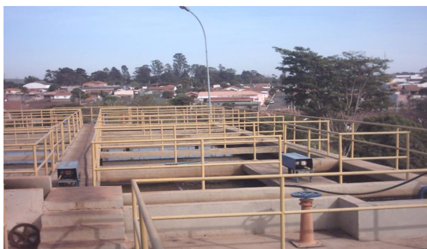
Figura 18. Floculadores, decantadores da ETA de Cordeirópolis.
