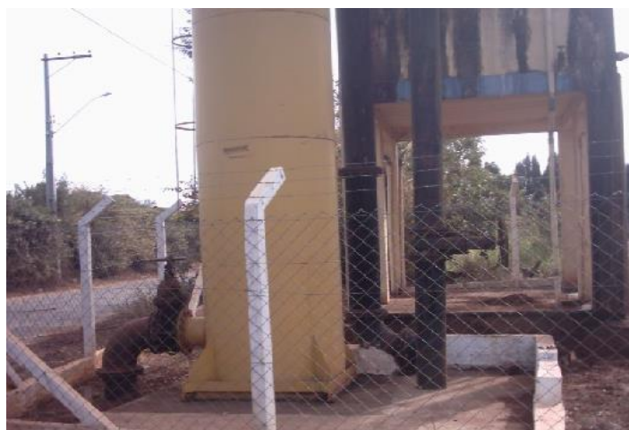
Figura 15. Tubulações de chegada e saída da água no reservatório que opera como caixa de passagem na Represa do Cascalho – Cordeirópolis – SP.
