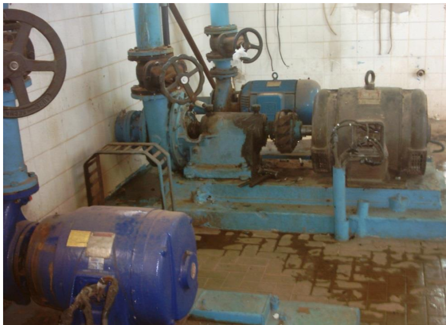
Figura 23. Casa de Bombas no. 01 com os 03 (três) conjuntos moto-bomba que recalcam água tratada da ETA para o reservatório Central de Distribuição.
