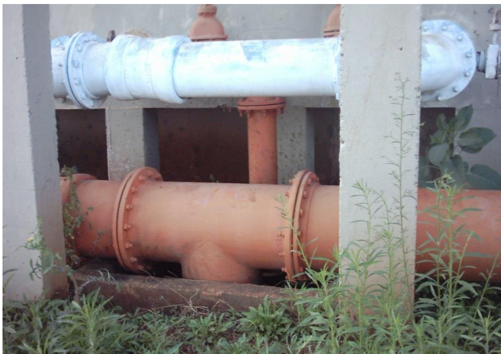
Figura 21. Saída da água decantada para os filtros da ETA de Cordeirópolis.
