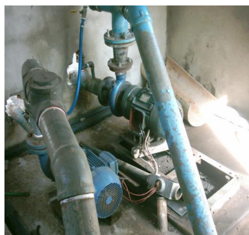
Figura 24. Casa de bombas no. 02 que recalca água tratada da ETA para o reservatório do Jardim Módulo e conjunto de moto bomba.
