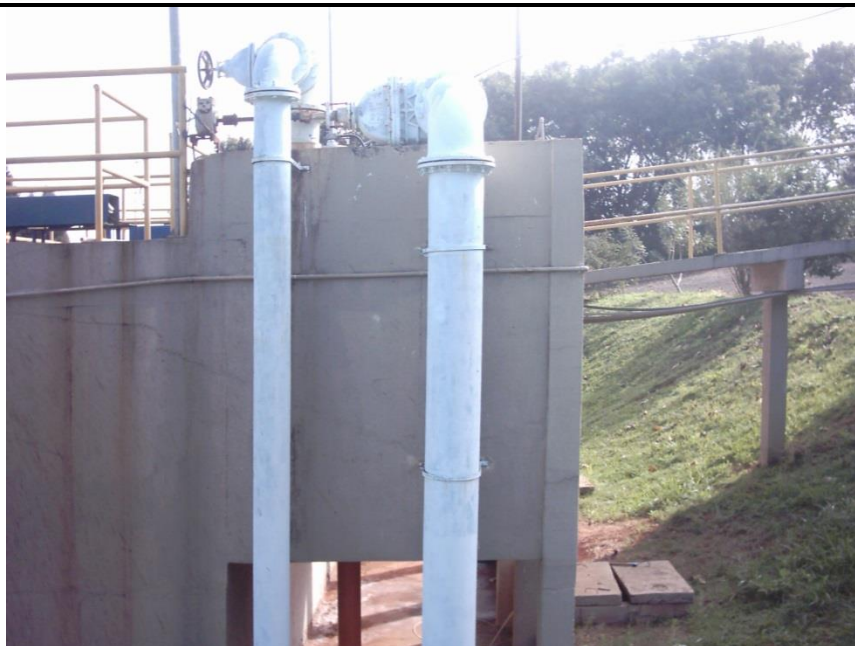
Figura 19. Adutoras de água bruta que chegam na ETA de Cordeirópolis.
