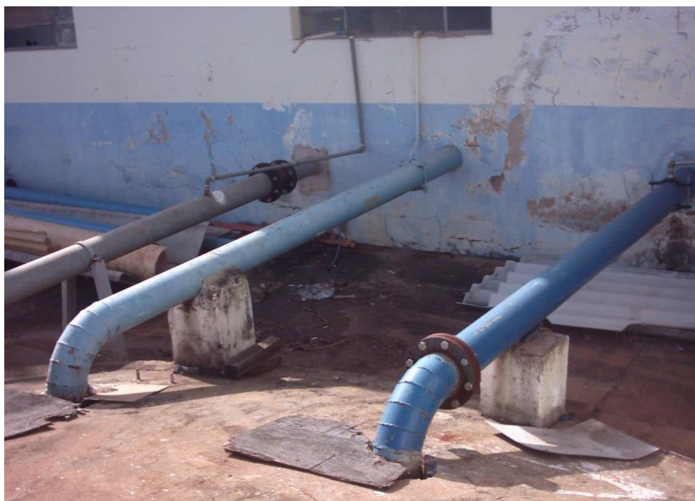
Figura 22. Tubulações de sucção da Casa de Bombas no. 01 da ETA.
