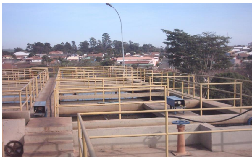
Figura 18. Floculadores, decantadores da ETA de Cordeirópolis.
