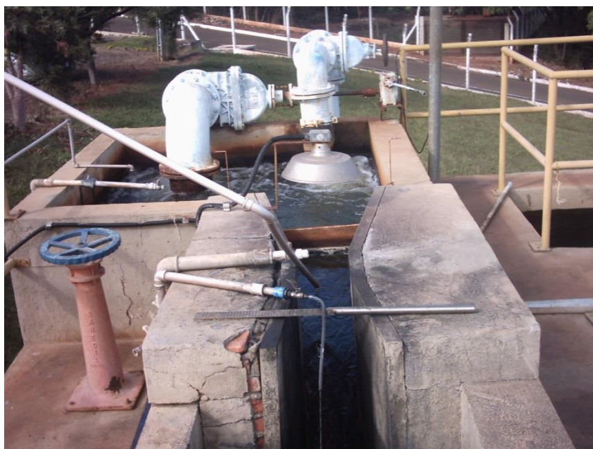
Figura 20. Calha Parshall, onde é feita a medição de vazão de chegada de água bruta na ETA de Cordeirópolis.
