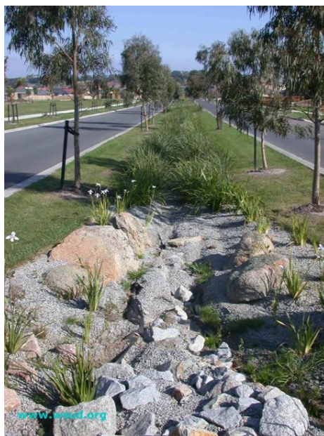
Figura 11. Trincheira de infiltração em canteiro central.
