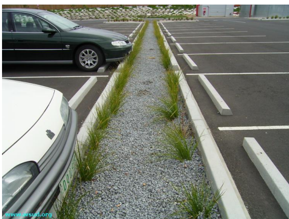
Figura 9. Trincheira de infiltração em estacionamento.
