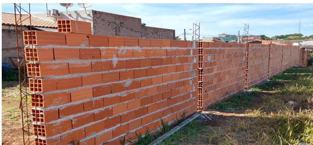
Figura 15: Programa habitacional “Meu Pedaco de Chão” com lotes dentro da malha urbana, restringindo sua expansão em áreas sem equipamentos públicos.
