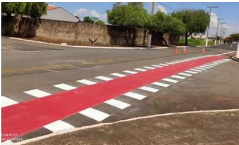
Figura 11: Instalação de ciclovias no município de Cordeirópolis-SP
