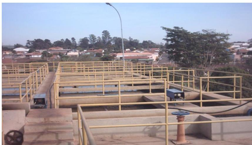
Figura 18. Floculadores, decantadores da ETA de Cordeirópolis.
