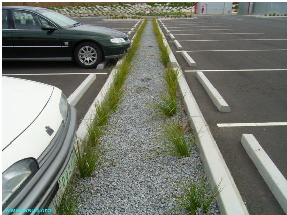
Figura 9. Trincheira de infiltração em estacionamento.
