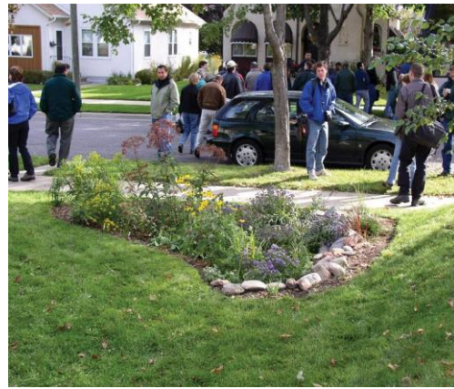
Figura 10. Bacias de bio retenção em área pública.
