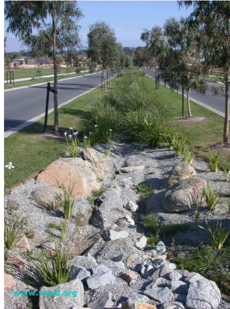
Figura 11. Trincheira de infiltração em canteiro central.
